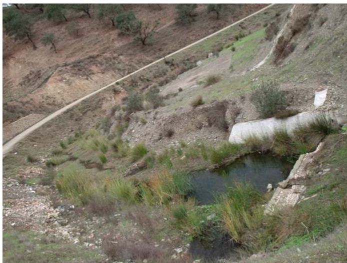
Figura 21 – ETAR (Fossa Séptica Colectiva) de Santana da Serra
