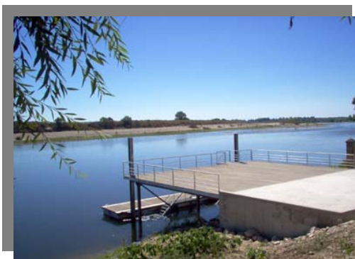
Figura 8 – Plataforma junto ao plano de água (Vila Nova da Barquinha)
